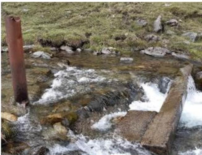
La démolition de vestiges d'un massif bétonné en lien avec l'hydroélectricité : les installations à démolir et évacuer représente 1 mètre cube pour le massif. Le tuyau en fer à démonter et évacuer a une dimension de 1,50 mètres de haut pour un diamètre de 2,25 mètres cubes.
