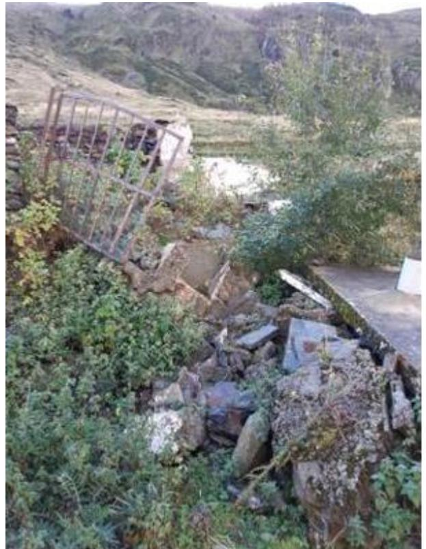
La démolition de l'ancienne cabane et son évacuation par hélicoptage représentent 11 mètres cubes pour la dalle et de 13 mètres cubes pour les massifs béton et murs.
