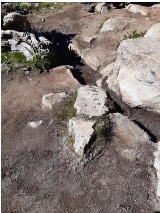
Le revers d'eau, la rigole et le caniveau sont des dispositifs d'évacuation des eaux de ruissellement créés pour canaliser et évacuer l'eau le long ou en travers du sentier.
