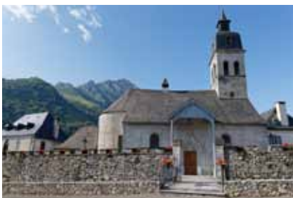
Eglise d'Arrens-Marsous © C. Cuenin- Parc national des Pyrénées
