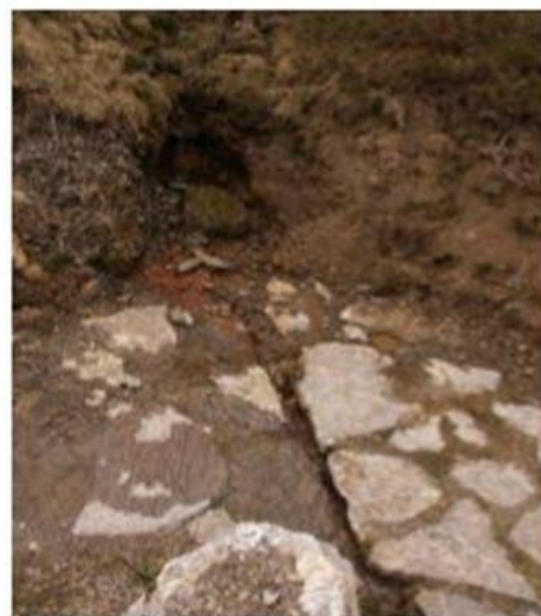
Figure 7 : exemple de revers d'eau
