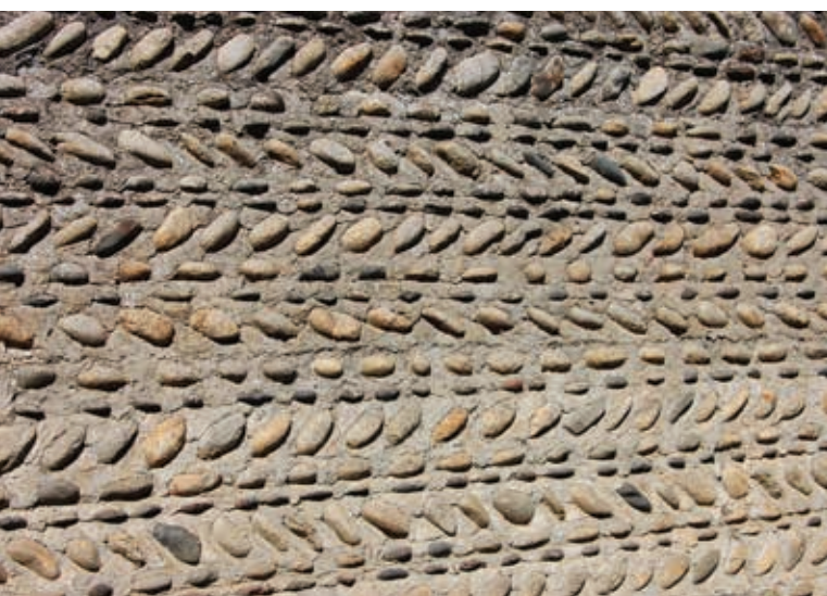
▲ Mise en œuvre en épis sur un mur non enduit. © C.A.U.E.65
