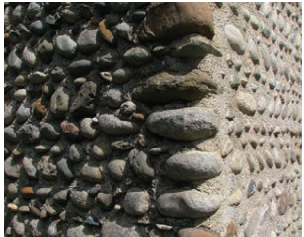
▲ Type de mur galet. © C.A.U.E.65
