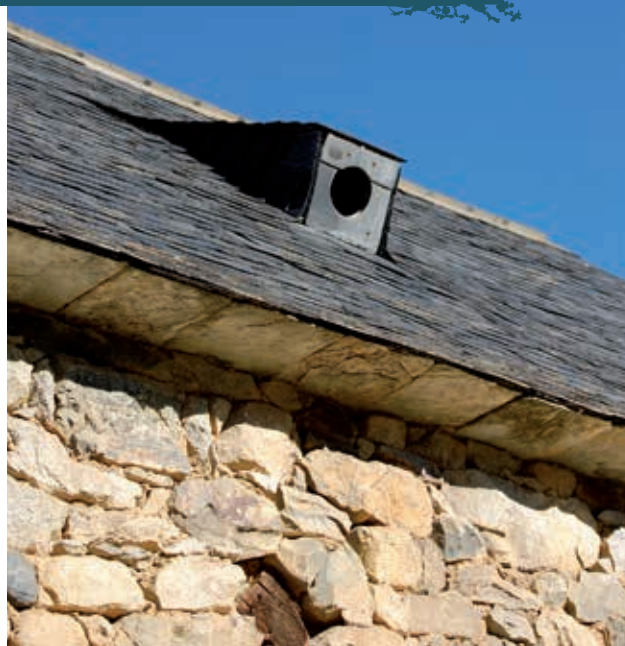
Un outeau permet l'aération du toit. © C.A.U.E.65
