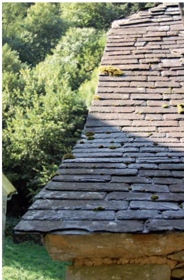
Disposition en rive et bas de toit des grandes ardoises. © C.A.U.E.65
