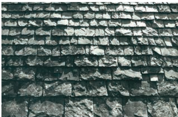
Assemblage d'ardoises à pureau dégressif. © C.A.U.E.65
