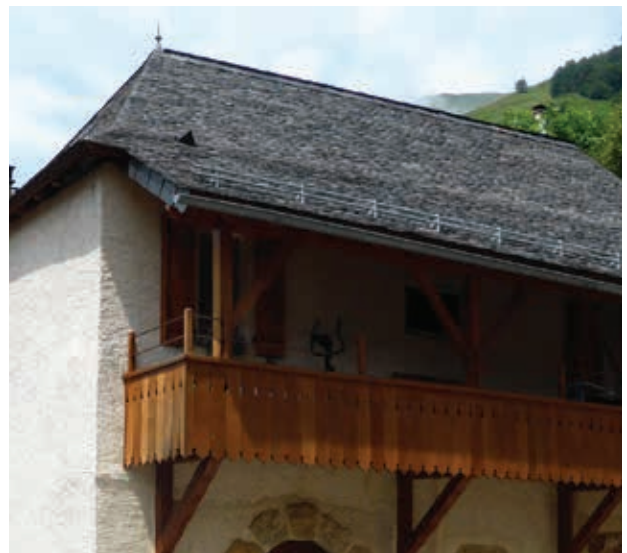
↗ Habillages de garde-corps modernes en planches verticales, venus probablement remplacer les anciens habillages en ardoises. Ces ouvrages renvoient à un style «chalet» moderne, mais ont l'avantage de garder le principe du calepinage vertical des bardages. © C.A.U.E.64
