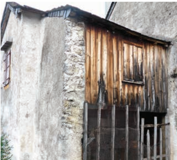
▲ Bardage en châtaigner d'un grenier surmontant une étable. © C.A.U.E.64
