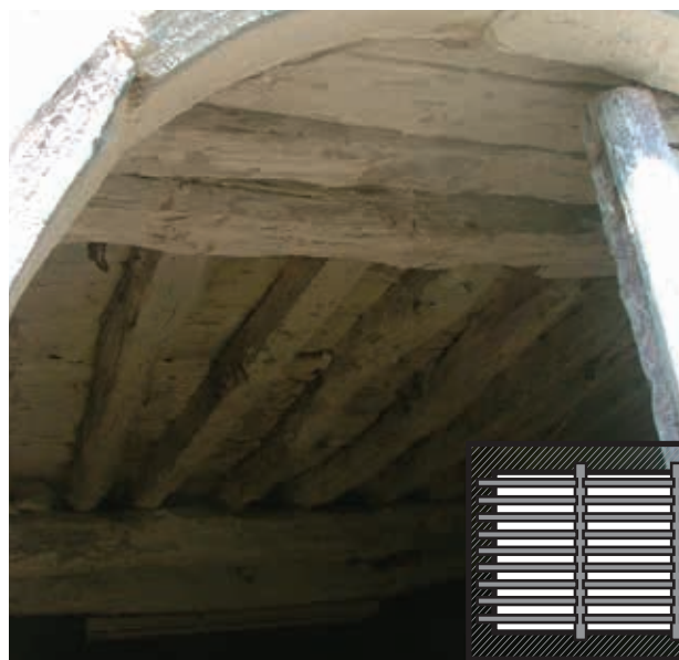
▲ Plancher à travure composée. © C.A.U.E.64
