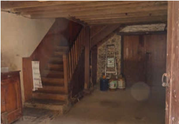
▲ L'utilisation dominante du chêne dans la maison ancienne : escalier, planchers, mobilier... © C.A.U.E.64
