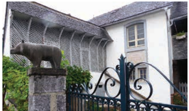
▲ Claustra en bois du poulailler surmontant la soue d'une ferme béarnaise. © C.A.U.E.64
