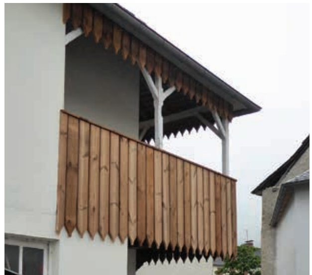
↗ Habillages de garde-corps modernes en planches verticales, venus probablement remplacer les anciens habillages en ardoises. Ces ouvrages renvoient à un style «chalet» moderne, mais ont l'avantage de garder le principe du calepinage vertical des bardages. © C.A.U.E.64
