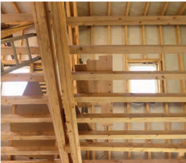
▲ Réfection de plancher en chêne dans le savoir-faire d'un « plancher à la française » avec des sections carrées et assemblages traditionnels. © C.A.U.E.64
