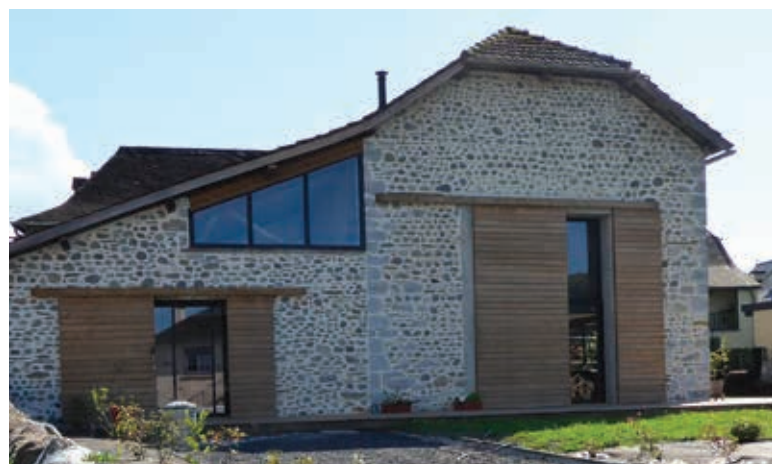
↗ Réinterprétation contemporaine des portes de granges à planches horizontales, sous forme de volets coulissants. © C.A.U.E.64
