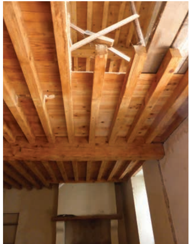
▲ Réfection de plancher en chêne dans le savoir-faire d'un « plancher à la française » avec des sections carrées et assemblages traditionnels. © C.A.U.E.64
