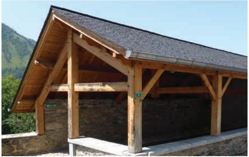
▲ Réfection contemporaine de lavoir avec savoir-faire de charpente traditionnelle. © C.A.U.E.64
