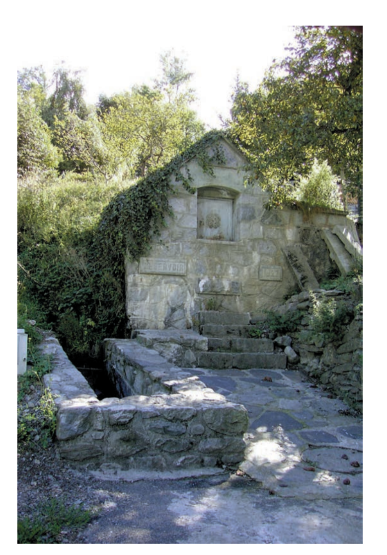
Esterre (65) - réservoir d'eau et canaux de distribution
