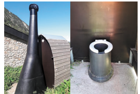
Dispositivo con separador de orina y un sistema de deshidratación de la materia y secado de la orina mediante circulación de aire, en el interior del depósito (Kazuba®).
