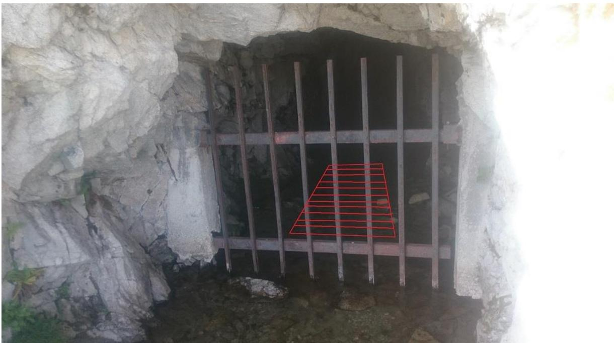
La seconde phase concerne la pose et l'enfouissement d'une cuve de 1000 litres dans la zone de déblais provenant de l'excavation de la galerie.
