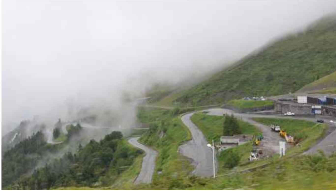
Route d'ascension à la station de Piau Engaly
