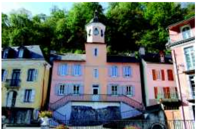
L'ensemble du bâti est inscrit dans la pente. La coloration des enduits allège la rigueur des façades ; les deux escaliers à double révolution donnent accès à un jardin anglais où l'on aperçoit la colonne dédiée en 1823 à la duchesse d'Angoulême
