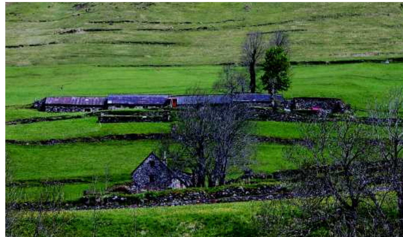
Granges encastrée dans le versant montagneux à Sers. Principe de l'alat : le toit à une seule pente épouse le terrain, ainsi l'avalanche ne rencontre aucun obstacle et passe tout simplement par dessus le toit. La grange est suffisamment enterrée pour que son toit à une seule pente prolonge le versant.
