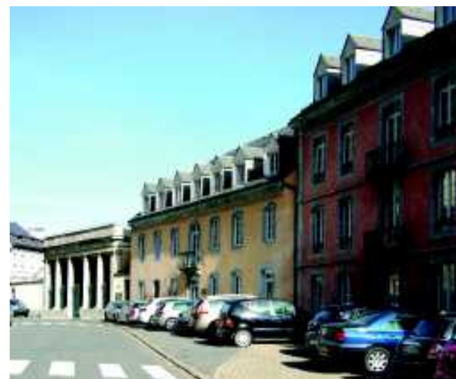
Rue des thermes : l'alignement des façades en continuité crée une légère courbe qui semble répondre à celle du Gave
