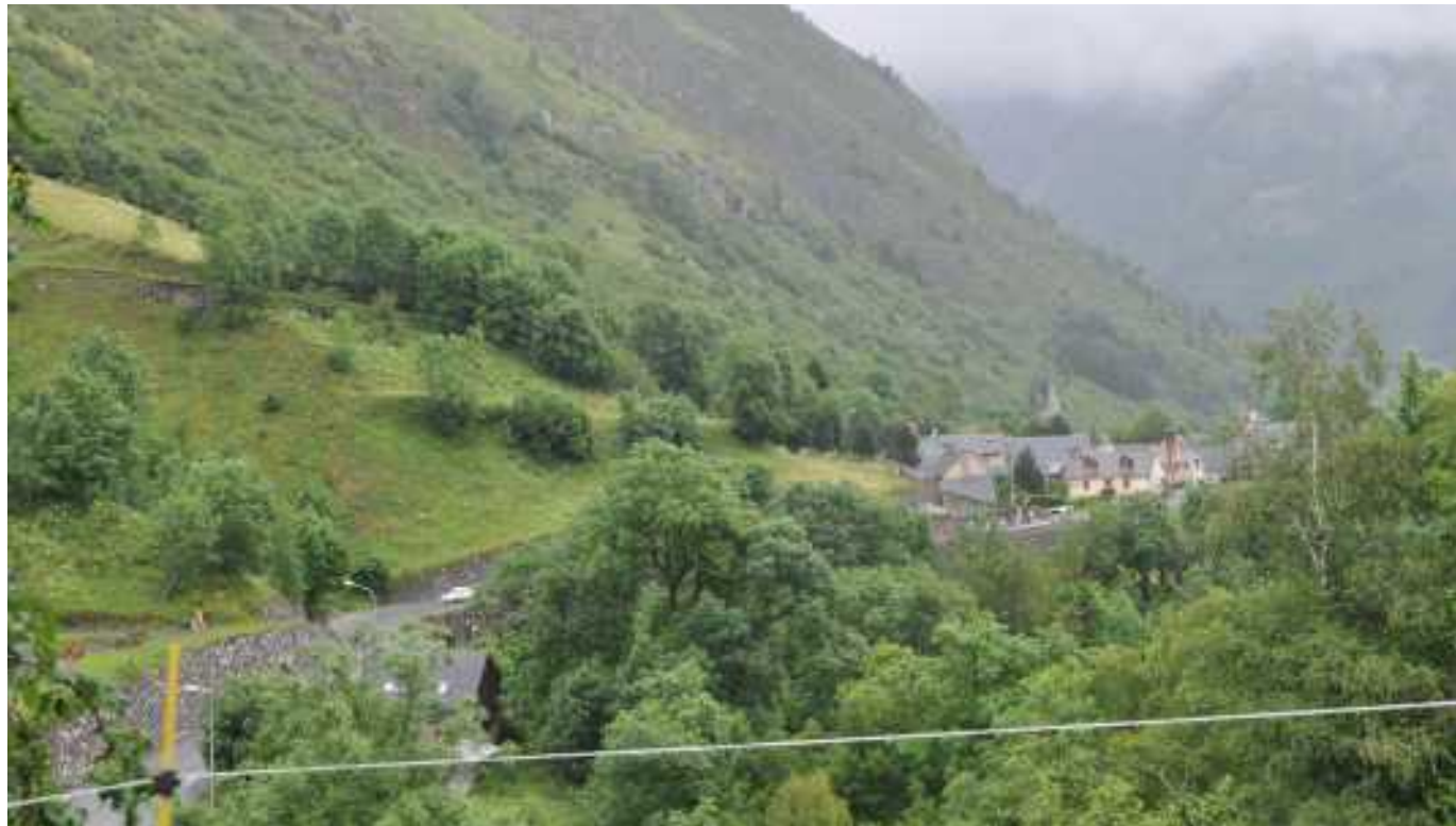
Silhouette de bourg de Fabian et murs de soutènement portant la route des lacs
