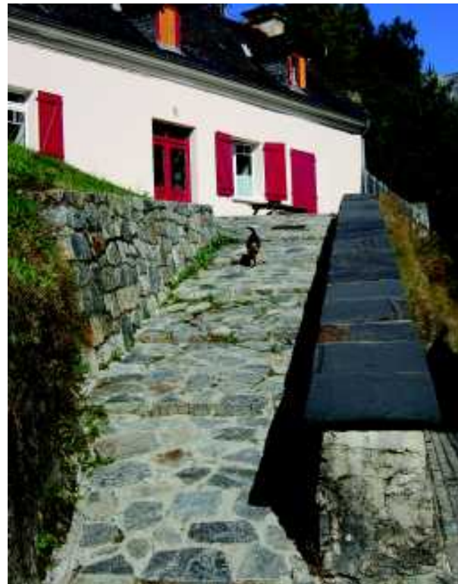
Reconstitution des herrades (chemins de pierre en réutilisant les matériaux locaux)
