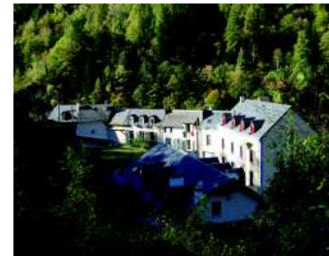
Rue de la Raillère: un alignement de façades en continuité sur la rue
