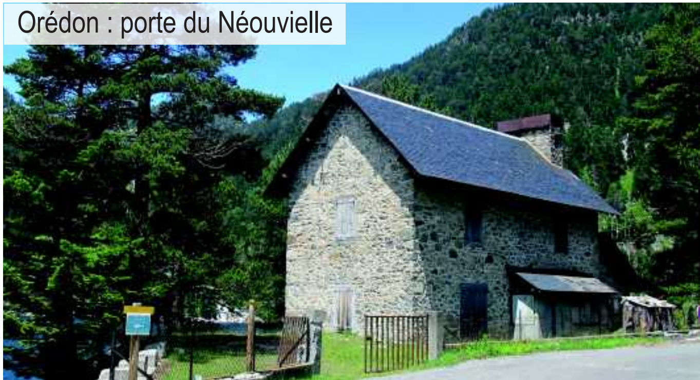
Refuge d'Orédon restauré avec les matériaux locaux
