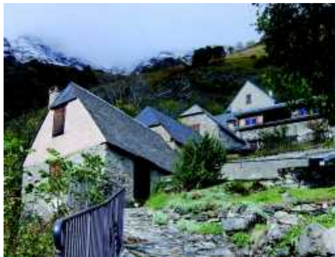
Constructions étagées : les lignes de faitage traduisent la pente
