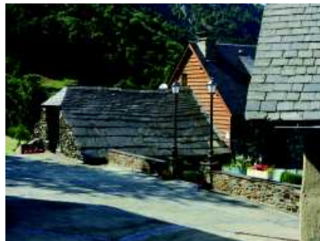
Grange dans le village implantée dans la pente
