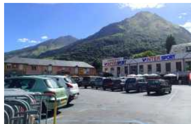
Commerce de centre-ville à Luz-Saint-Sauveur : un bâtiment qui tranche avec l'architecture environnante et un parking très impactant
