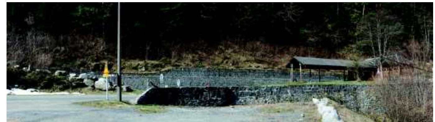
Murs de soutènements sur la route du Cambasque
