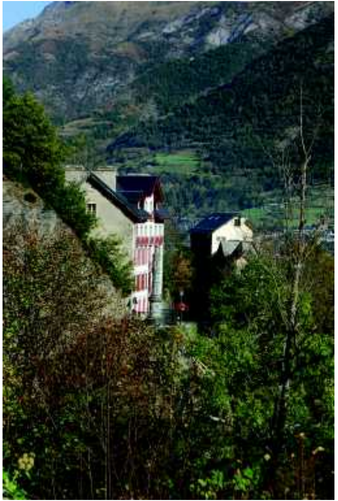
Les façades sont tournées vers le Sud afin de bénéficier d'un ensoleillement maximal.
