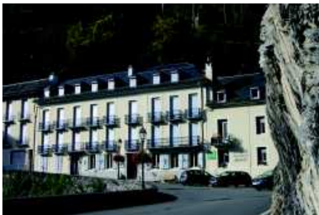
La plupart des bâtiments sont des résidences consacrées à l'accueil des curistes
