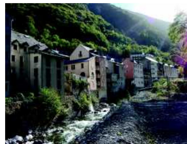
Restructuration des bords du Gave après les inondations de juin 2013
