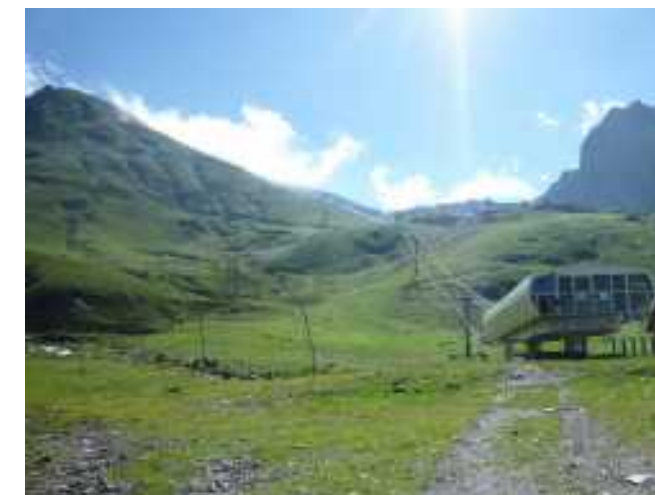
Remontées mécaniques de Barèges
