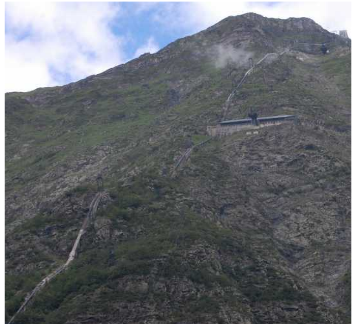
Haute station de pompage de Pragnères et conduites forcées
