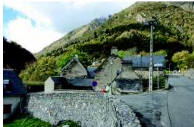
Le nouveau bâti s'appuie sur les murs de soutènement
