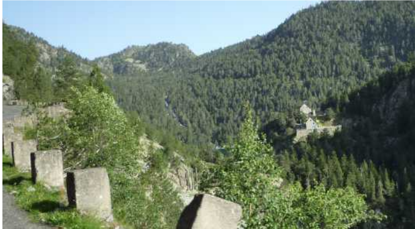
Ancienne route créée pour la réalisation des barrages qui offre aujourd'hui un accès spectaculaire au coeur du Néouvielle
