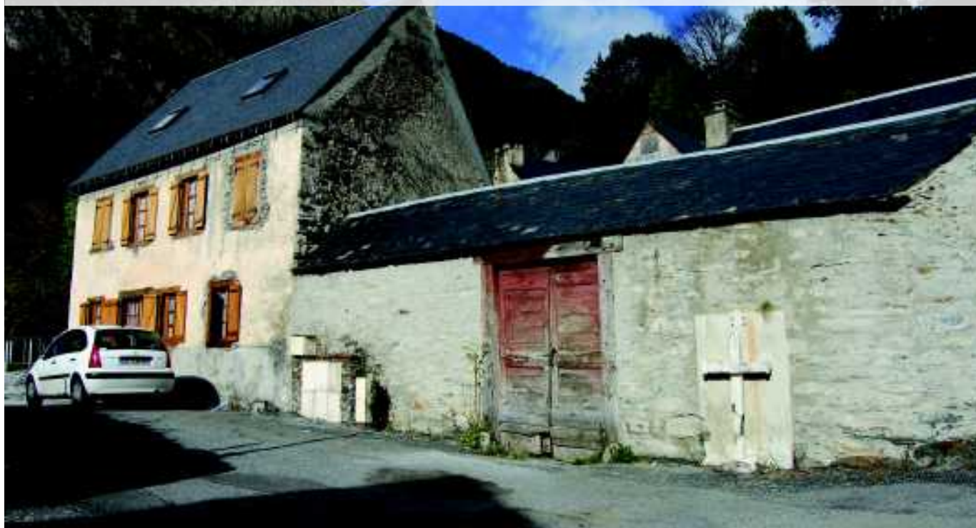
Front bâti sur rue formé par une partie habitation et une annexe d'une ferme à Fabian
