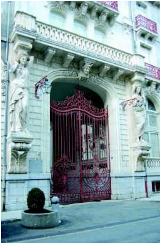
2- La façade de l'hôtel Continental résidence est classée monument historique
