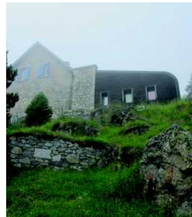
Chalet refuge : Murs de soutènement en pierres sèches
