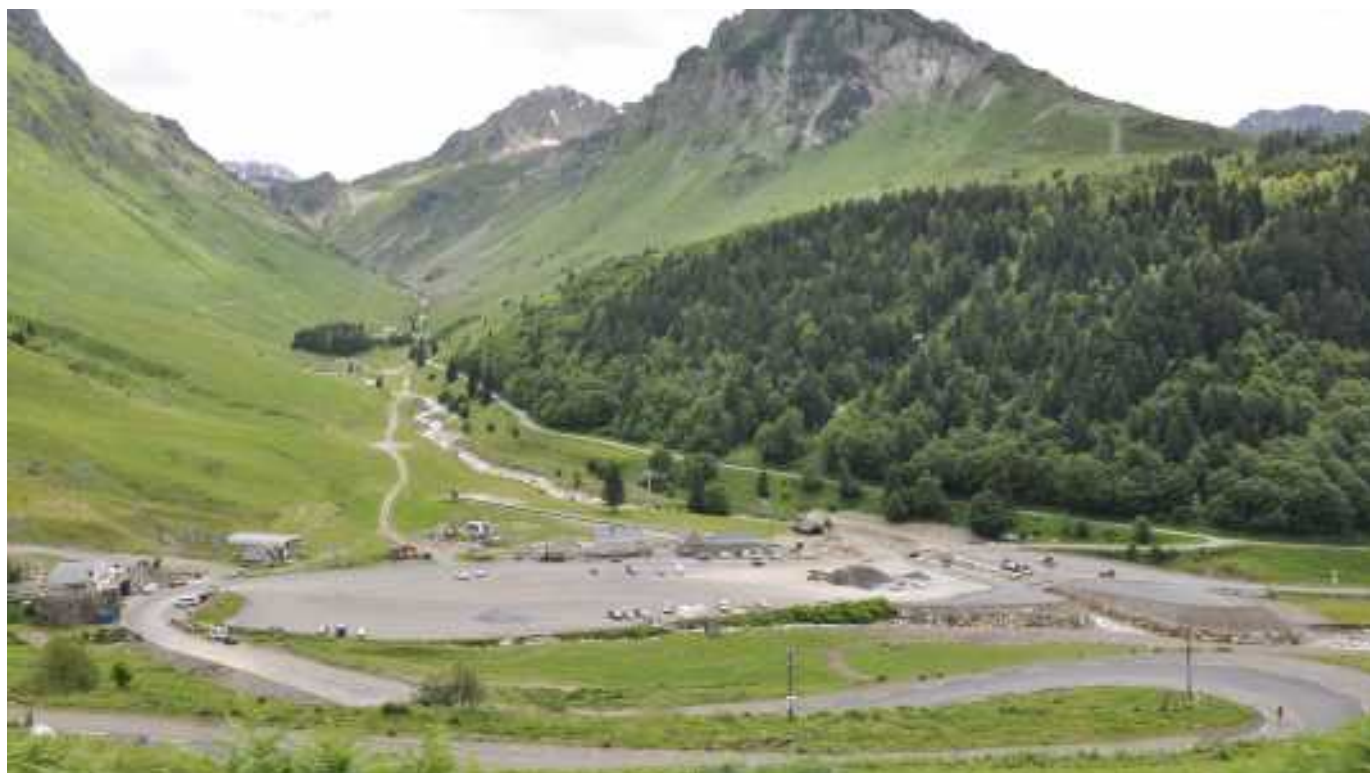
Aménagement des stationnements à Barèges (col du Tourmalet)
