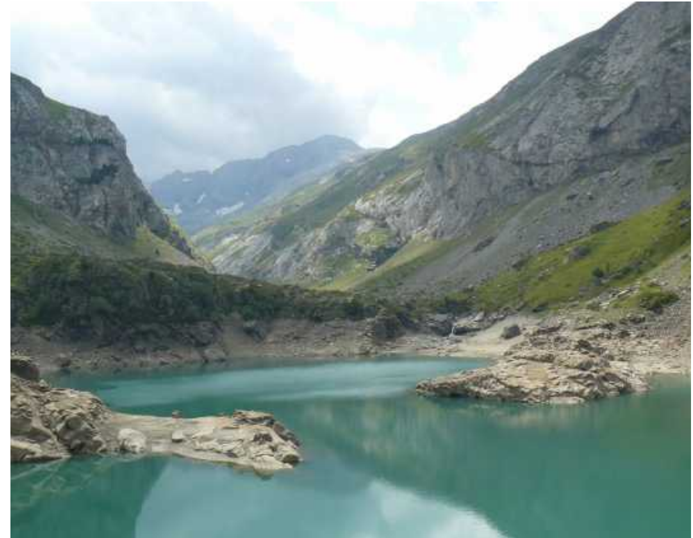
Couloir du gave d'Estaubé menant au cirque, avec en premier plan le barrage du lac des Gloriettes
