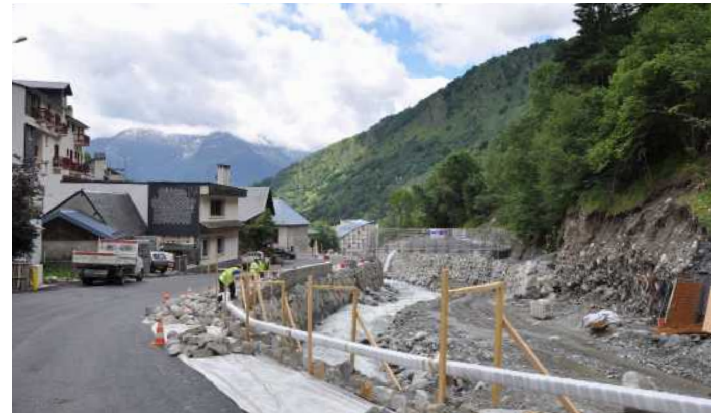
Aménagements de protection contre les crues du Bastan
