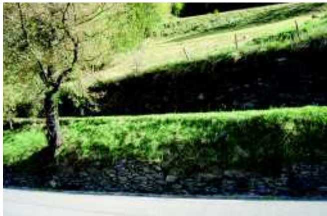
Soutènement route de Luz
