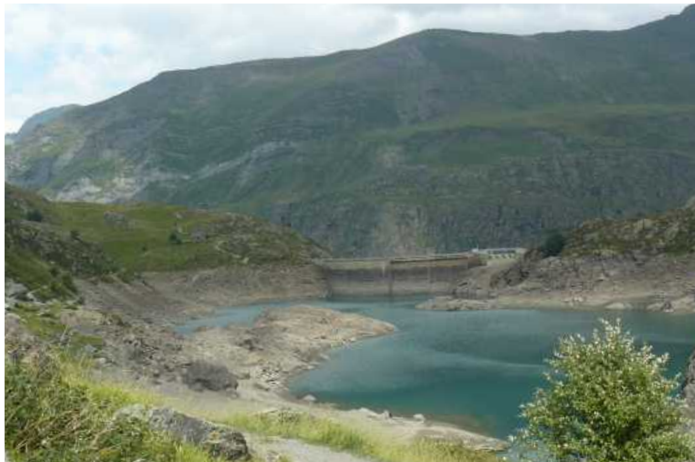
Barrage des Gloriettes
