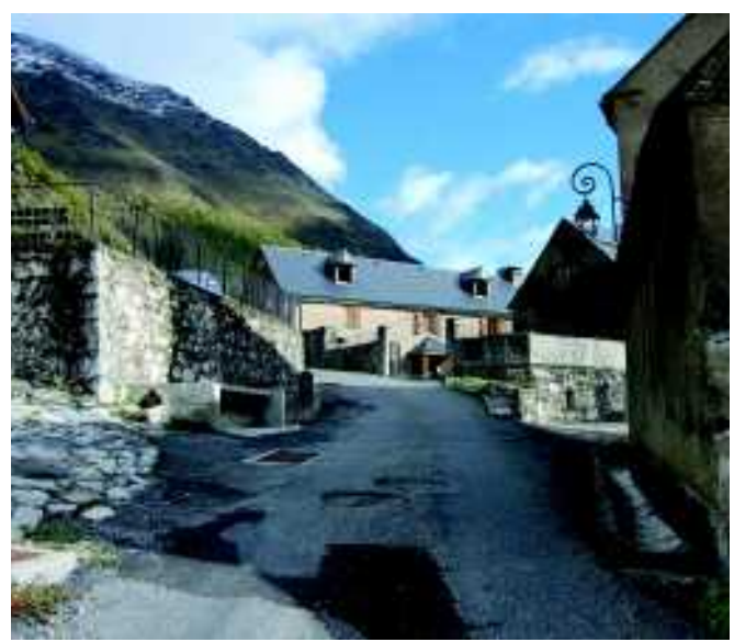
Rue en forte pente
