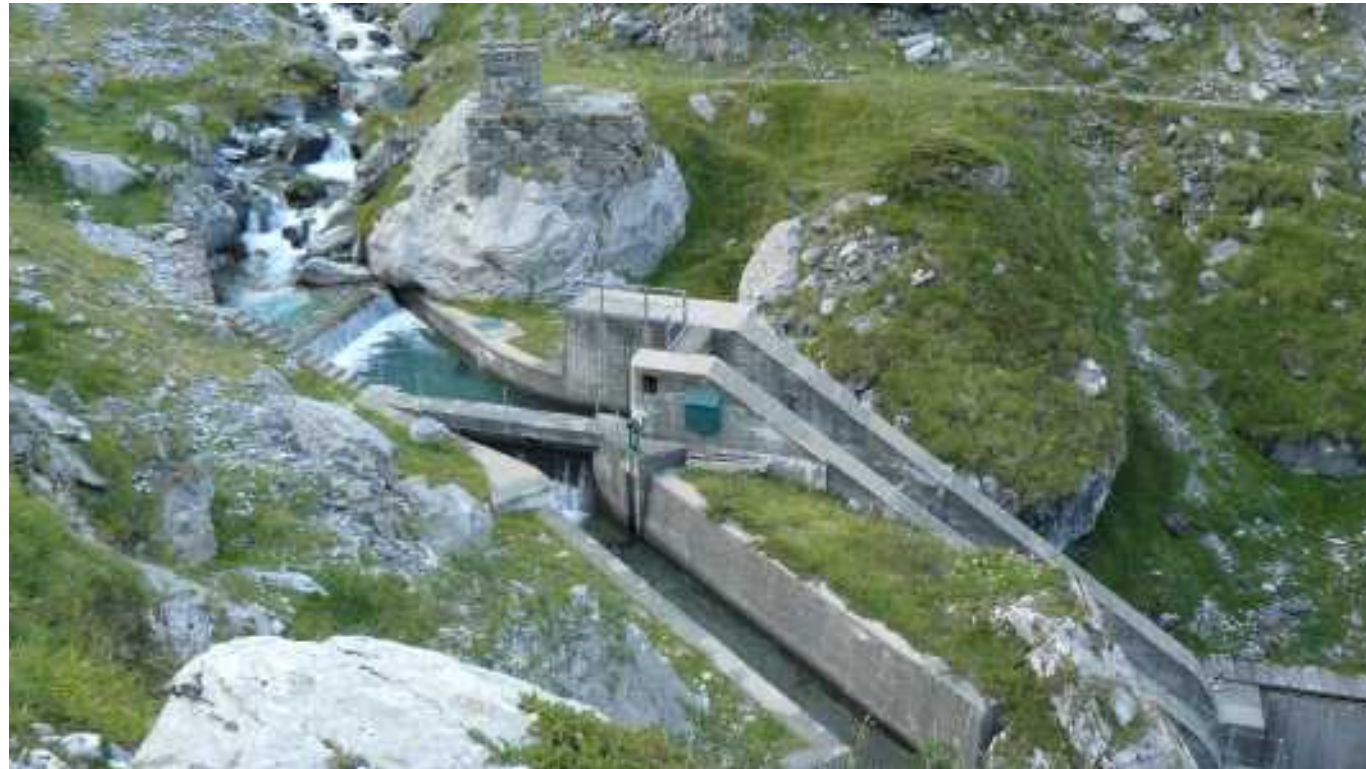
Ouvrage d'eau de captage à Troumouse
