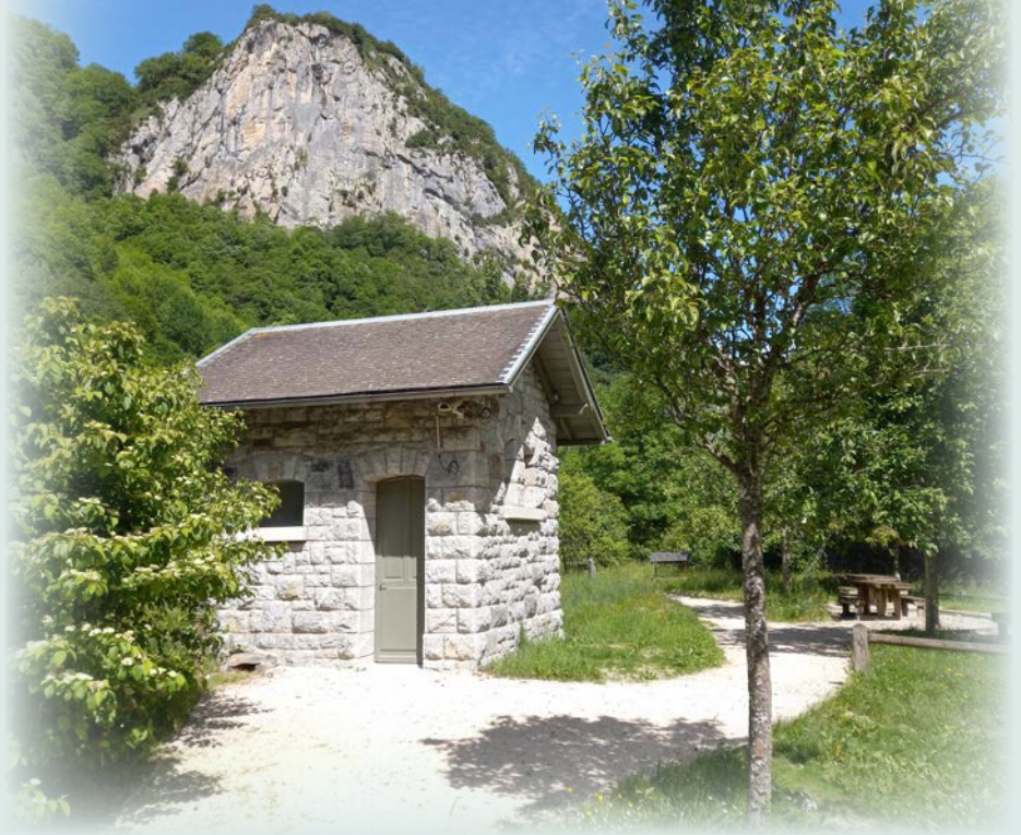
Toilettes sèches à Etsaut
