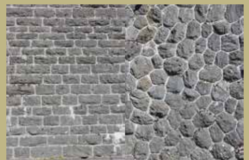
En vallée d'Aspe (PNP) : deux appareillages différents sur des ouvrages ferroviaires
