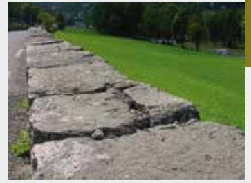
Cette tête d'un mur maçonné en vallée de Cauterets (PNP) a été réalisée avec les plus gros moellons disponibles (dalles). Leur seul poids assure l'essentiel de la tenue de la tête.
