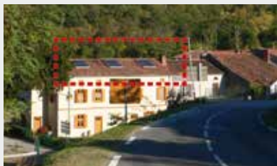
L'intégration des panneaux solaires aurait gagné à ce que ces équipements soient directement intégrés à la toiture.
