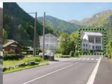
L'usine hydroélectrique blanche caractérise l'entrée de bourg et renseigne sur la présence de la rivière. Elle agit comme le marqueur de l'entrée de bourg.
