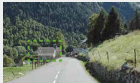
L'entrée de village se situe au niveau de l'avancée de la chapelle qui marque le paysage et qualifie l'entrée de bourg.
