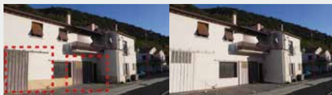
La façade présente des éléments de composition standardisés (portes de garage) peu identitaires. Celles-ci mériteraient d'être repeintes en clair pour se fondre mieux dans la façade et redonner une place à la volumétrie du bâti.
