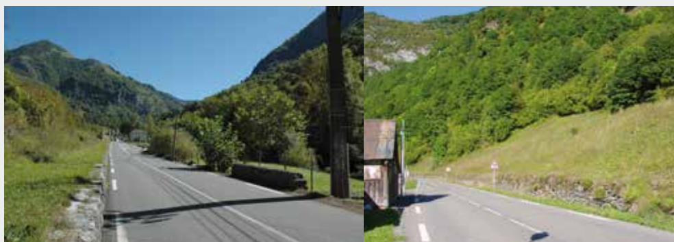
Le pied de talus en muret permet une transition harmonieuse entre les bas-côtés et la chaussée et cadre la vue. La rue est bien délimitée et sûre.
