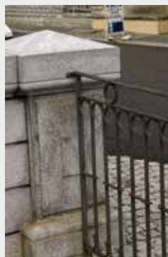
En vallée d'Aure (PNP), travail de taille de pierre et de ferronnerie propre à mettre en valeur le cours d'eau à sécuriser.
