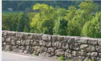
Mur maçonné à joints repoussés dans la vallée de Cauterets (PNP)
