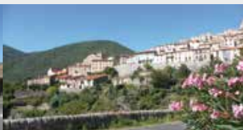
La couleur d'enduit uniforme et l'unité des toitures permettent de s'attarder sur le rythme caractéristique des ouvertures du village.
