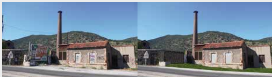
Cette ancienne usine pourrait retrouver un peu de son rayonnement passé en retraitant le pied de façade par une surface enherbée (contrastant avec son crépi).
