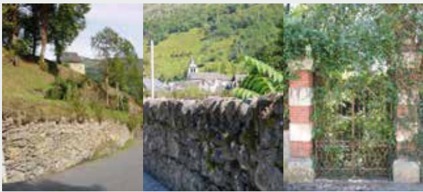
Mur de soutènement en pierre sèche ; mur en pierres et galets ; portail.
