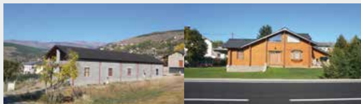
Façade en remplissage parpaings non enduite
