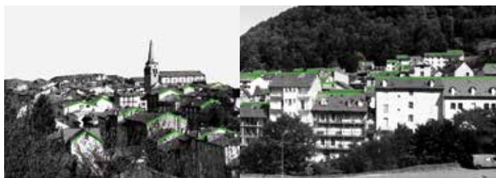
Toitures à deux versants
