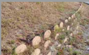
Soutènement préfabriqué sur l'îlot central d'un giratoire sur le versant sud du Carlit (PNRPC). Est-on au cœur de la Cerdagne ou en Beauce ?...
