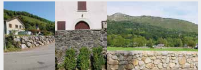
Murs aux appareillages non identitaires ou au jointoiment trop visible.
