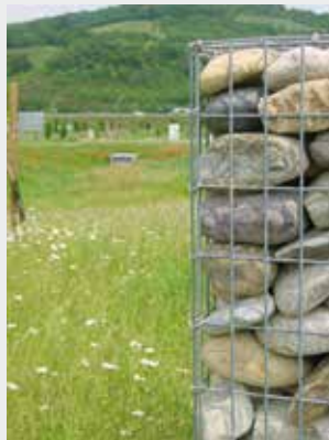
Gabions remplis de galets
