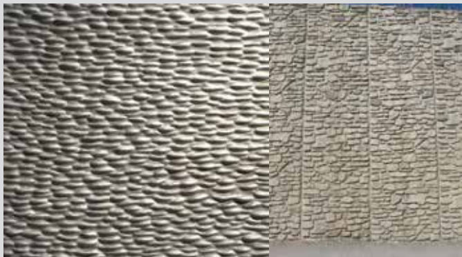
A gauche un détail d'un mur matricé reprenant l'appareillage de petits galets. A droite vue plus globale d'un mur de béton matricé sur le plateau du Capcir (PNRPC)
