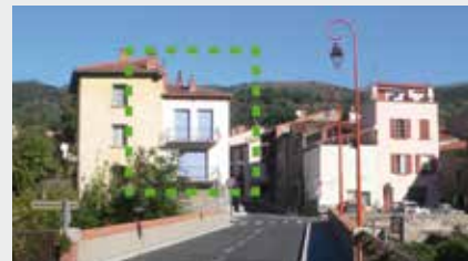
Sur cette entrée de bourg, le rythme des ouvertures verticales n'est pas perturbé par les balcons réalisés en fer forgé fin.
