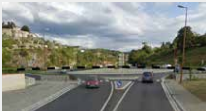
Giratoire au profil discret laissant des vues sur le village
